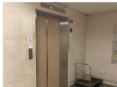
搬入物が小さく、精密機器がある場合は こちらのエレベーターをご利用ください 扉サイズ 幅1m×高さ2.1m エレベーターサイズ 間口 幅1m×高さ2.1m 内 幅1.8m×奥行1.58m×高さ2.35m 重量: 1,150kg(17名まで)
