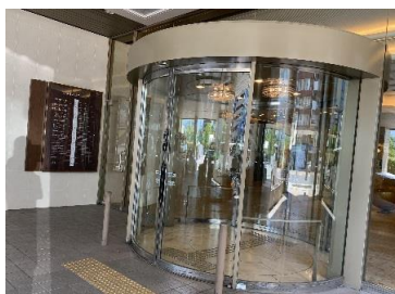
1F 車寄せの入口です。 扉サイズ 幅1.4m×高さ2.35m
